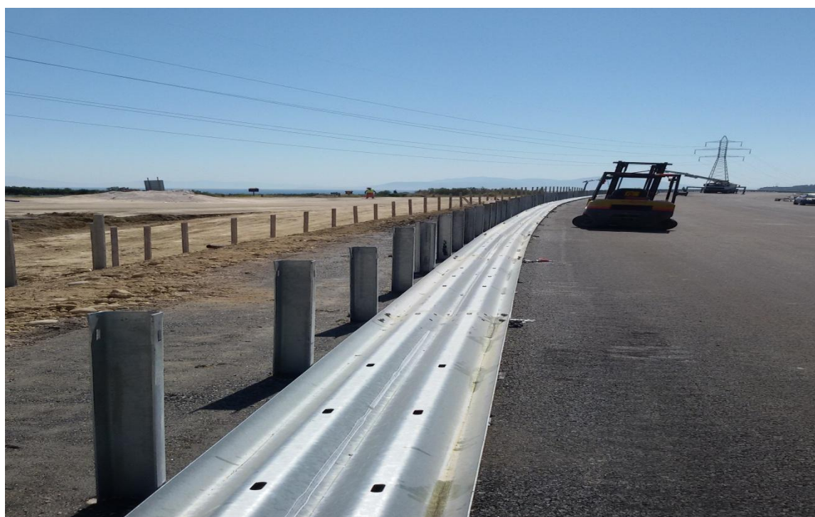
Κ.ρ. 33+300-37+000 R.B. – Εγκατάσταση στηθαίων ασφαλείας
