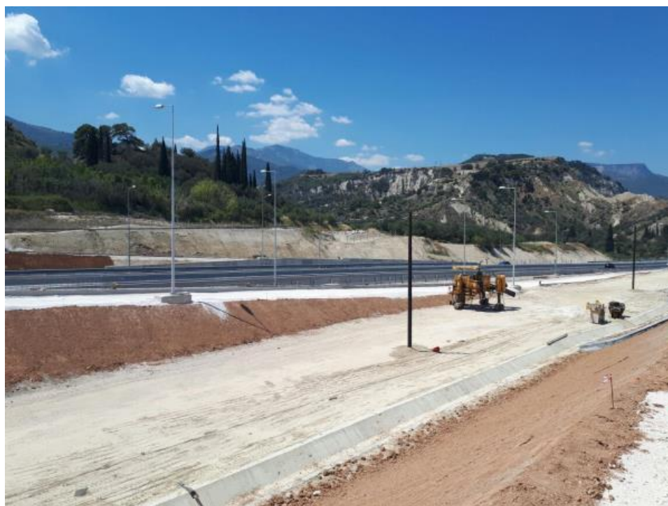
Κόμβος Λυκοποριάς : Εγκατάσταση, καλωδιώσεων, βάσεων και στήλων φωτισμού
