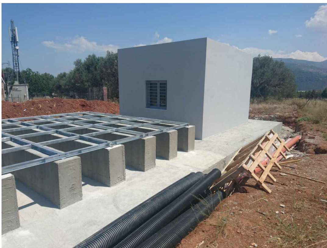
Κατασκευή υποδομών γεώτρησης στη χ.θ. 88+040
