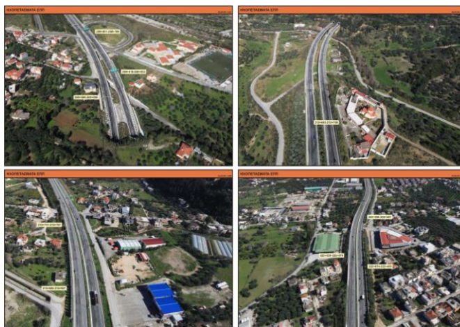
θέσεις εγκατάστασης αντιθορυβικών πετασμάτων στην ΕΠΠ
