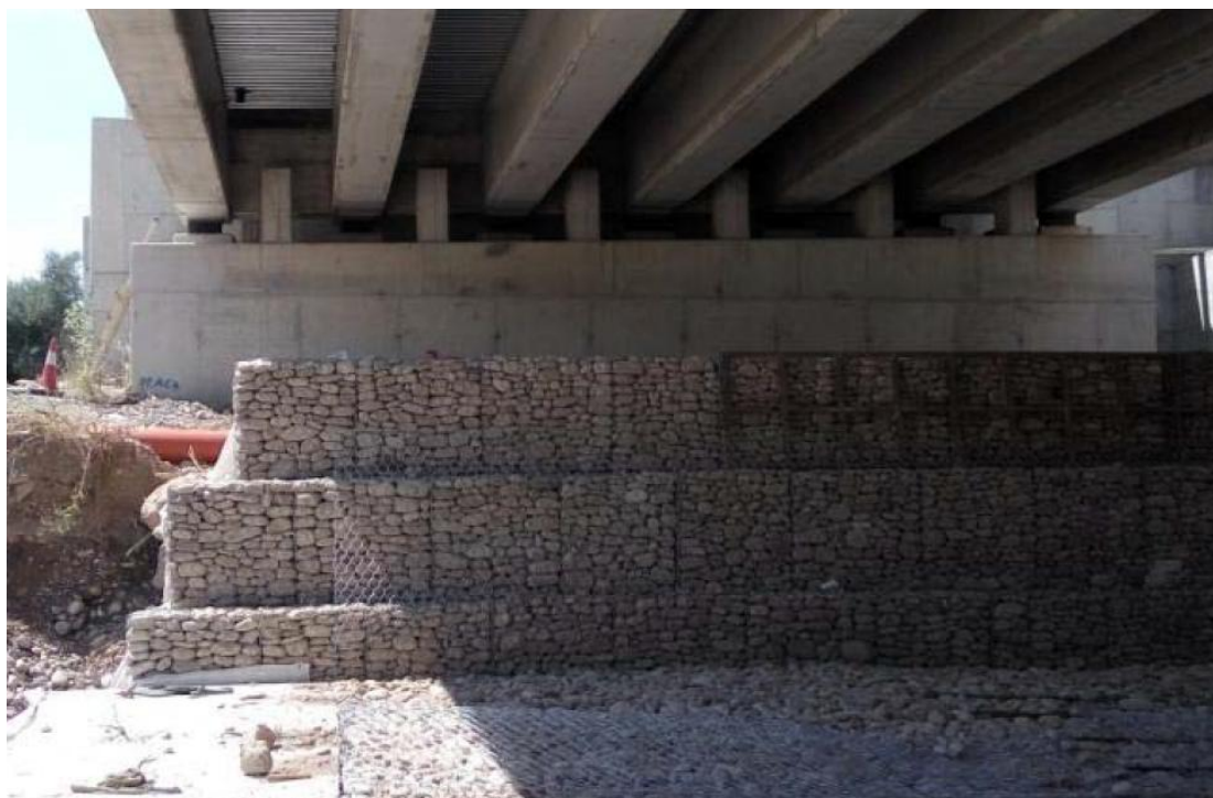
Διευθέτηση κοίτης ποταμού Φοίνικα: κατασκευή του M2-A3 με σαρσανέτια
