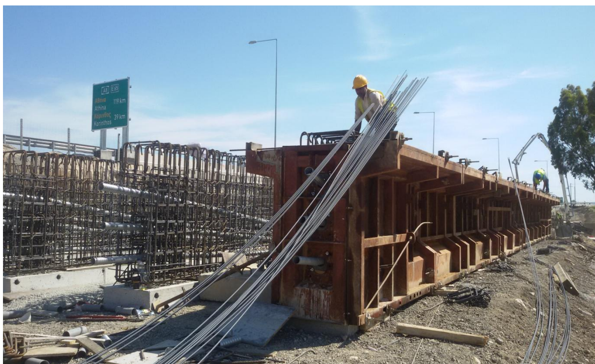
Β211 (SR KP 32+763) – προκατασκευή στοιχείων γέφυρας
