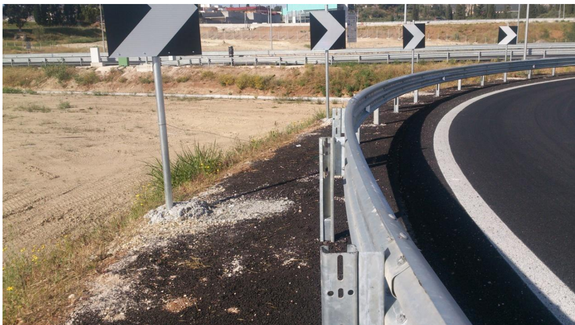
Εγκατάσταση πινακίδων σήμανσης
