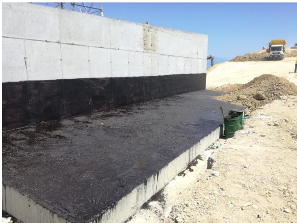
R293 – Κατασκευή τοιχίου αντιστήριξης
