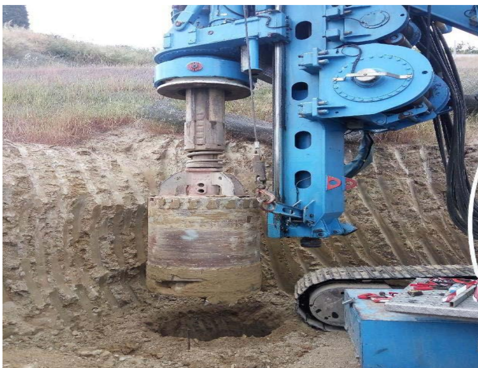
0530 53+174-53+247 L.B.: γεωτρήσεις για την τοποθέτηση κολώνων
