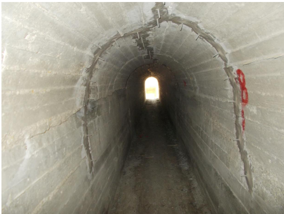
Εργασίες συντήρησης στο φρέατιο C27
