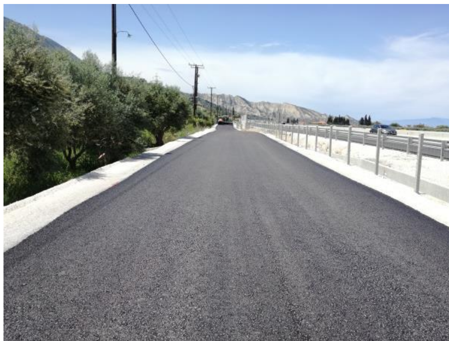
SR033L – Εργασίες ασφαλτόστρωσης σε παράλευρη οδό
